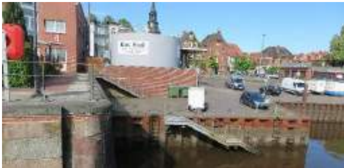
Abb. 37 und 38: Salztorschleuse Oben: Plattform, Unten Treppe
