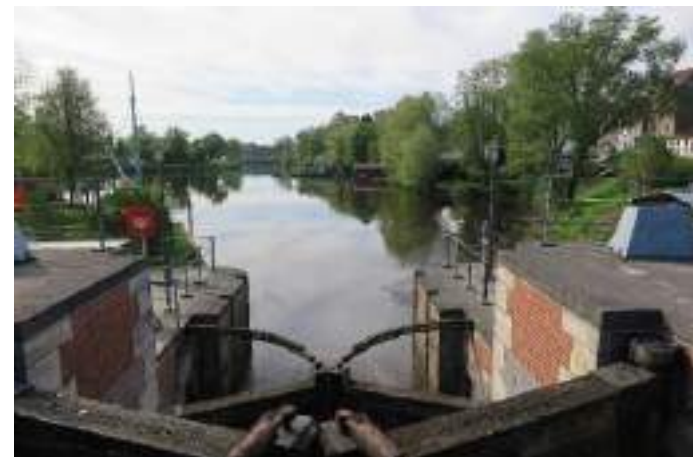
Abb. 11 und 12: Oben: Burggraben, Unten: Salztorschleuse
