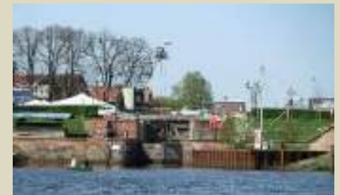
Abb. 39: Kanufahrer vor Salztorschleuse
